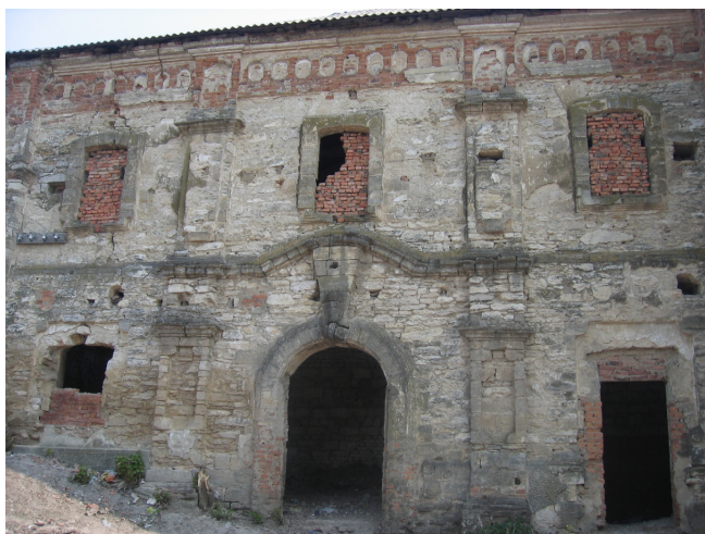
Здание синагоги. Современный вид.
