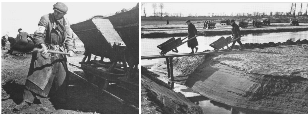
На земляных работах
