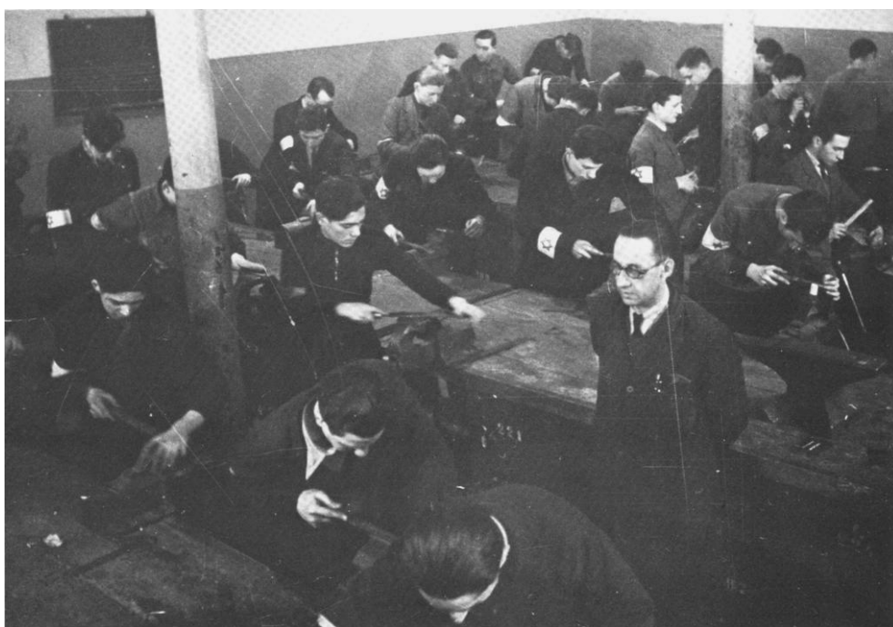
На слесарных работах
